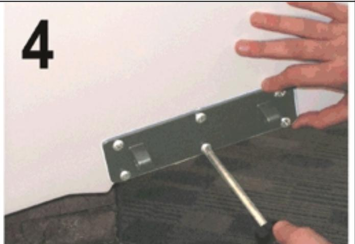
**Установите петлю:** Воспользуйтесь небольшим количеством водостойкого герметика для каждого из отверстий. Не используйте чрезмерную силу при закручивании болтов – при возникновении такой необходимости рассверлите (расширьте) отверстия.
