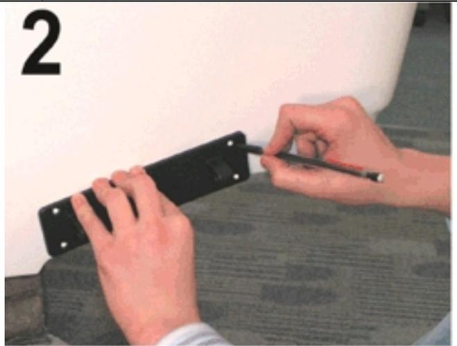
**Отметьте отверстия для установки:** Используйте петлю в качестве трафарета. Проверьте, есть ли возможность установки петли на том же месте с противоположной стороны лодки (симметрично).
